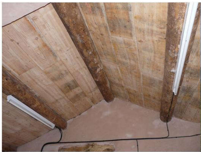
Pose de planches en mélèze au plafond du four communal par Jean-Jacques et Henri, ceci afin d'avoir une meilleure étanchéité du bâtiment aux intempéries comme à la poussière.
